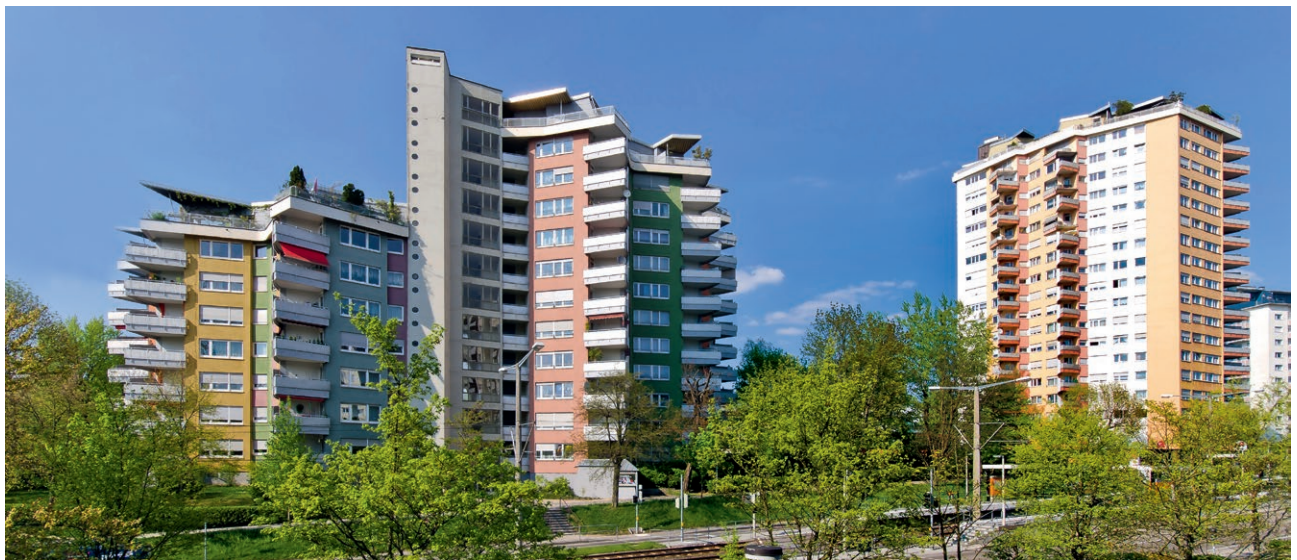
Stuttgart-Rot, Hochhaus „Julia“.
